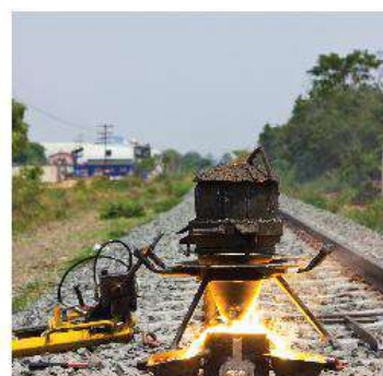
▲ Hình 13.1. Phản ứng nhiệt nhôm để hàn đường ray
